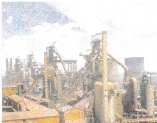
Uno degli impianti per l'acciaio a Durgapur
